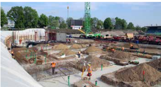
Die ersten Wände stehen, Grundleitungen, die Bodenplatte wächst
