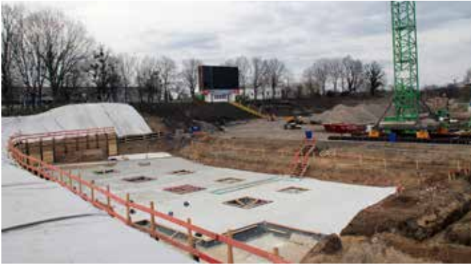
Erste Teile der Bodenplatte für die neue Südtribüne
