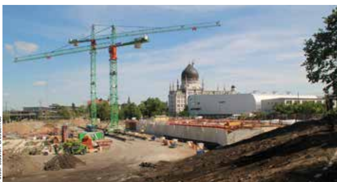
Das Untergeschoss der Südtribüne ist zu zwei Dritteln fertig.
