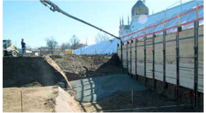
Der erste Beton fließt
