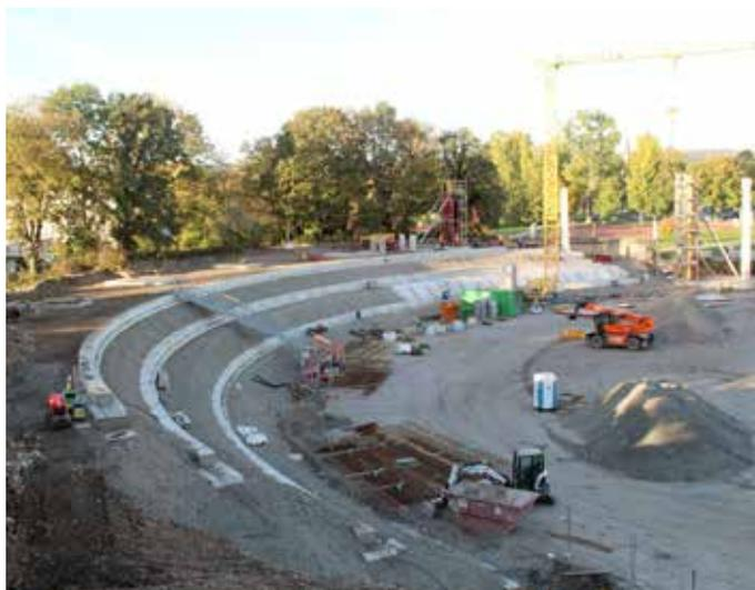
beiten des Innenausbaus starten können. Auch die sogenannten Zahnbalken, welche die Fertigteile für die Zuschauertribüne tragen werden, wurden eingebaut. Parallel sind in der Westkurve bereits die ersten Pfeiler für das Lichtband zu sehen. Dieses Lichtband schließt als Stahlkonstruktion mit Flutlicht das gesamte Stadionoval ein.
