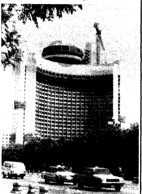
Der Bau des neuen Interhotels Peking soll im Oktober abgeschlossen werden. Mit einer Höhe von 104 m verfügt das Gebäude über 34 Etagen – drei davon sind unterirdisch. Foto: ZB/HNA
